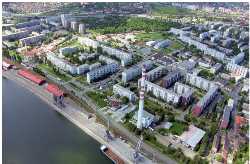
Pohľad na tepelný zdroj COM-therm v Komárne
